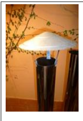
Colocação do chapéu
