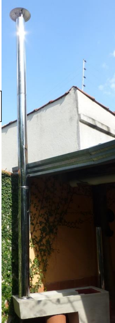
Instalação da chaminé
