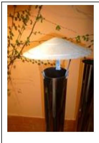
Colocação do chapéu
